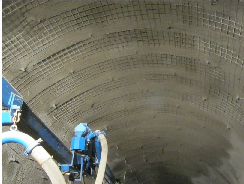
Bild 11: Auftrag Spritzbetonbalken
