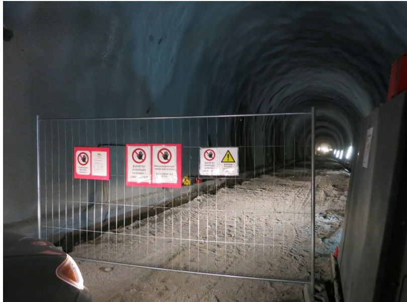
Bild 12: Absperrung eines frisch aufgetragenen Spritzbetonbereiches im Tunnel
