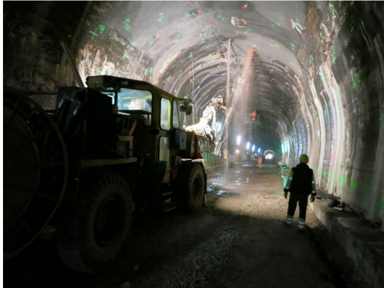
Bild 9: Bohren und Versetzen der SB-Anker
