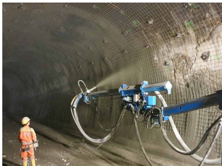
Bild 10: Arbeitsgang Vorspritzen
