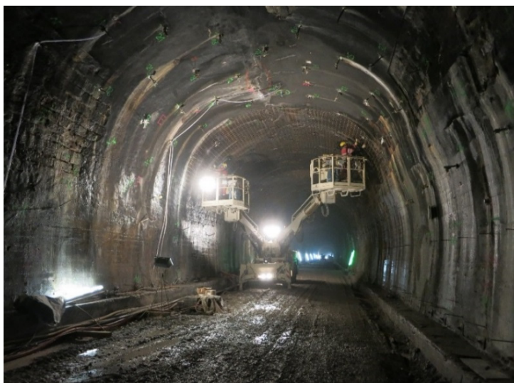
Bild 8: Im Hintergrund - Befestigung der Bewehrungsmatten, im Vordergrund sind die unterschiedlichen Bestandsoberflächen zu sehen – links Sandsteinmauerwerk, in der Firste Spritzbeton, rechts Ortbeton.
