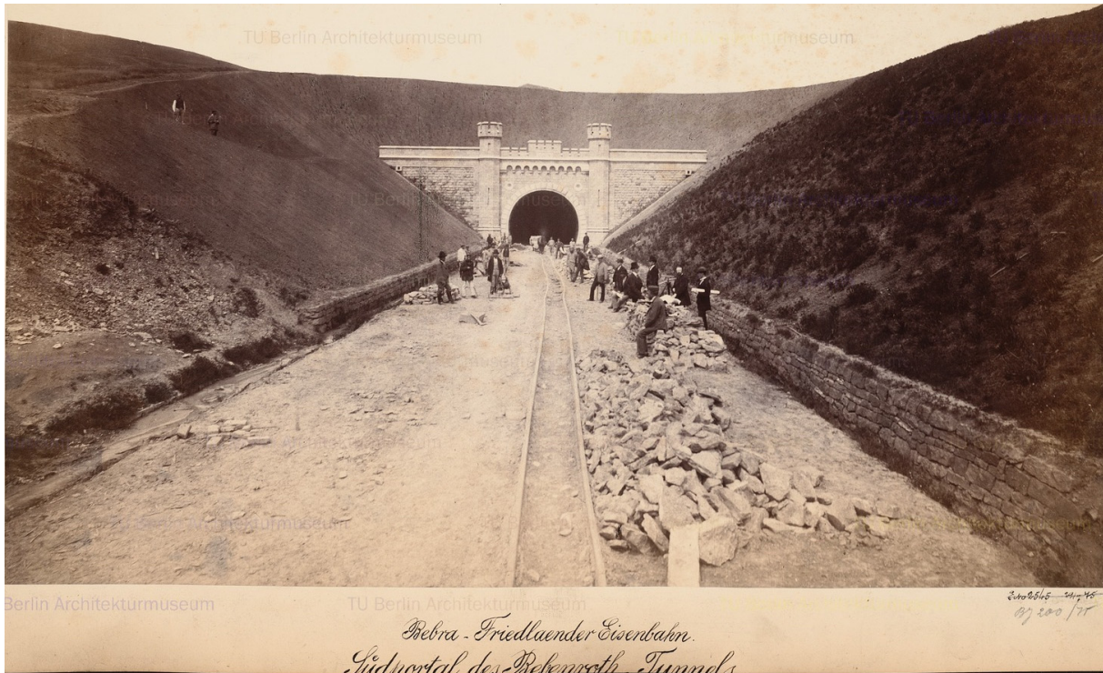
Bild 1: Bauarbeiten am Bebenrothtunnel um 1875
